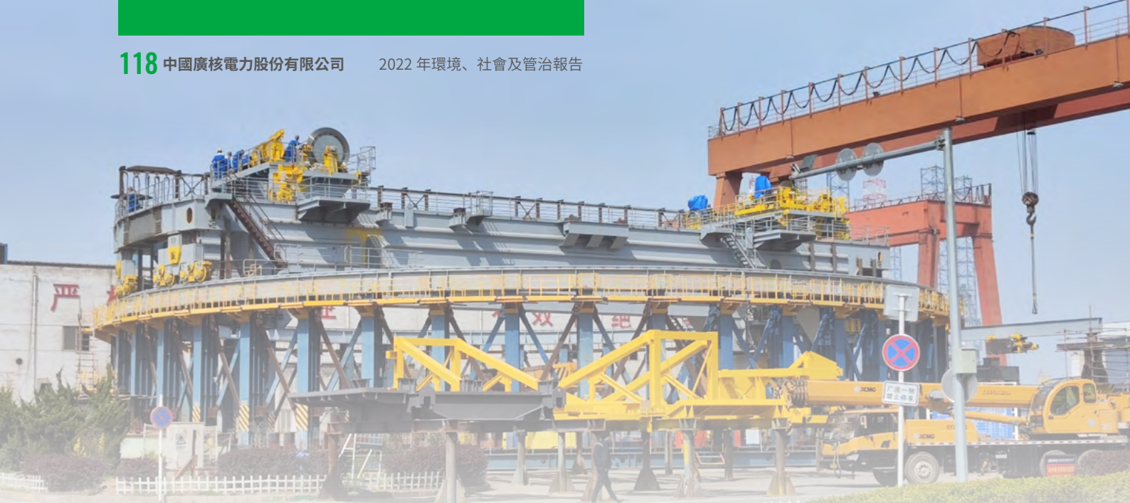
2022年5月，根據新冠疫情防控形勢，工程公司安排專人長期駐廠，在廠內開展惠州2號機組環吊調試工作
